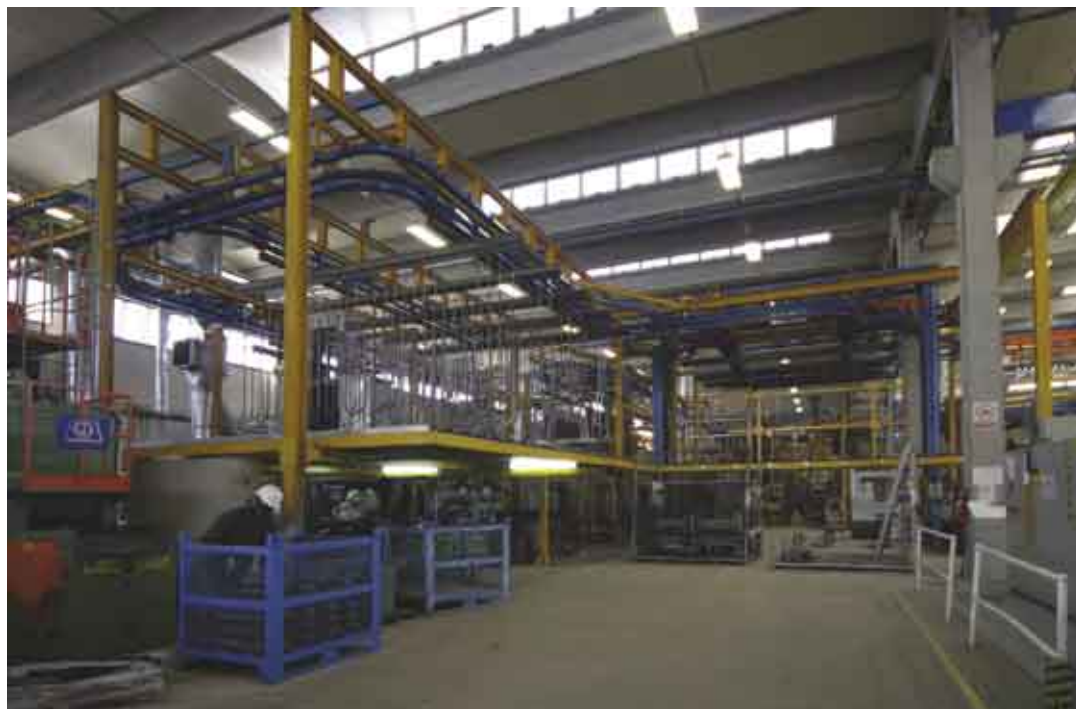
Fig. 6 - La zona di carico sul birotaia.
