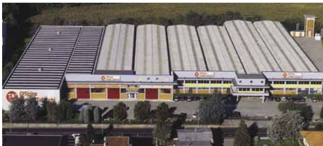
Fig. 1 - Veduta aerea delle Officine Taiocchi a Curnasco di Treviolo, in provincia di Bergamo
