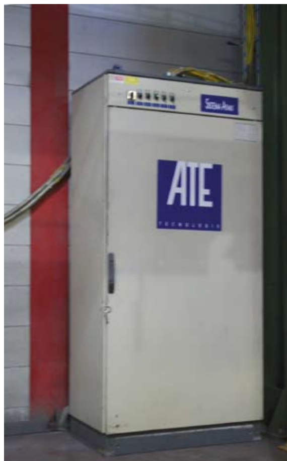
8 - Il sistema Atimix della ATE: neutralizza le cariche elettrostatiche di disturbo che si creano durante la fase di verniciatura.
