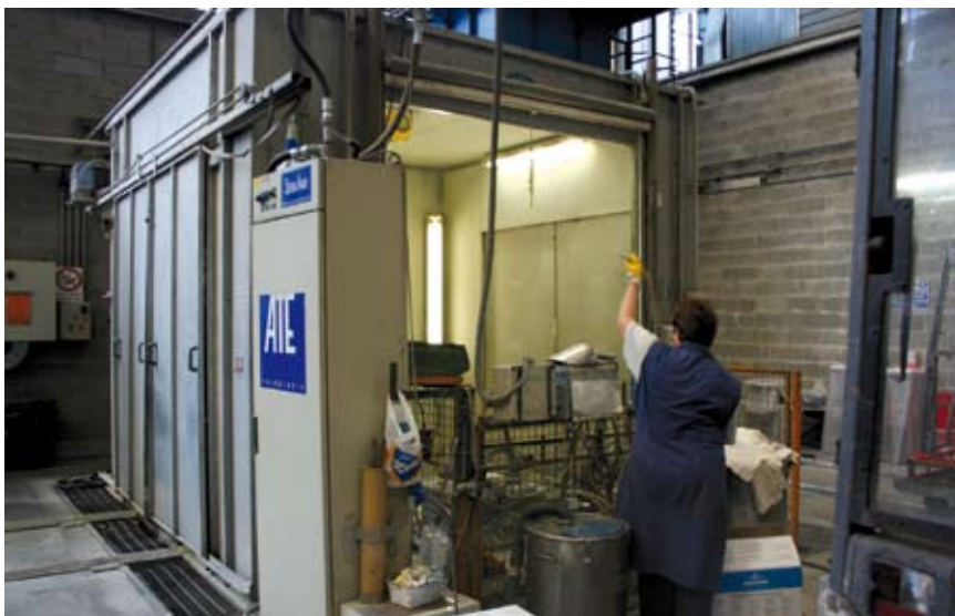
8 - Cabina manuale di applicazione polveri per cabine monolitiche. Sulla sinistra è visibile uno dei primi modelli Atimix installati su questo impianto.
