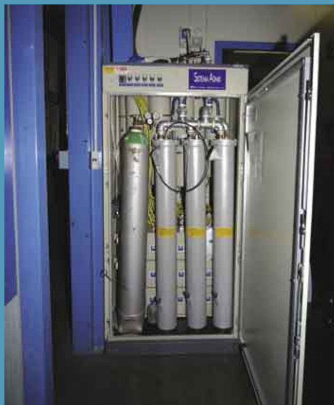
Fig. A - Il contenitore aperto del sistema Atimix: si notino la compattezza e le dimensioni ridotte dell'apparecchiatura
