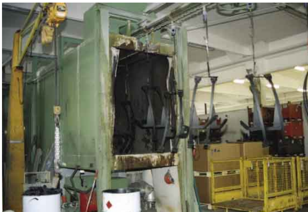
Fig. 1 - L'ingresso dei pezzi nel tunnel di pretrattamento: sgrassaggio iniziale, fosfosgrassaggio e risciacquo
